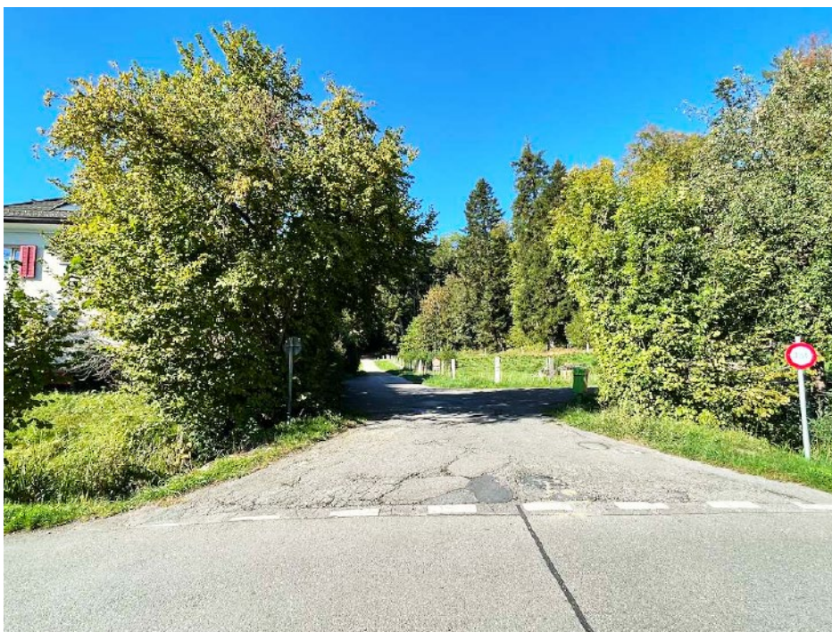
Die Gönhardbrücke über den Stadtbach: Bald bekommt sie eine neue, schützende Abdichtung.
