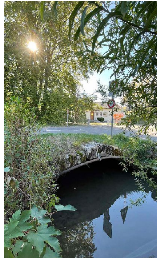
Die Brücke im Chaibegässli: Hier wird sorgfältig ausgebessert statt neu gebaut.
