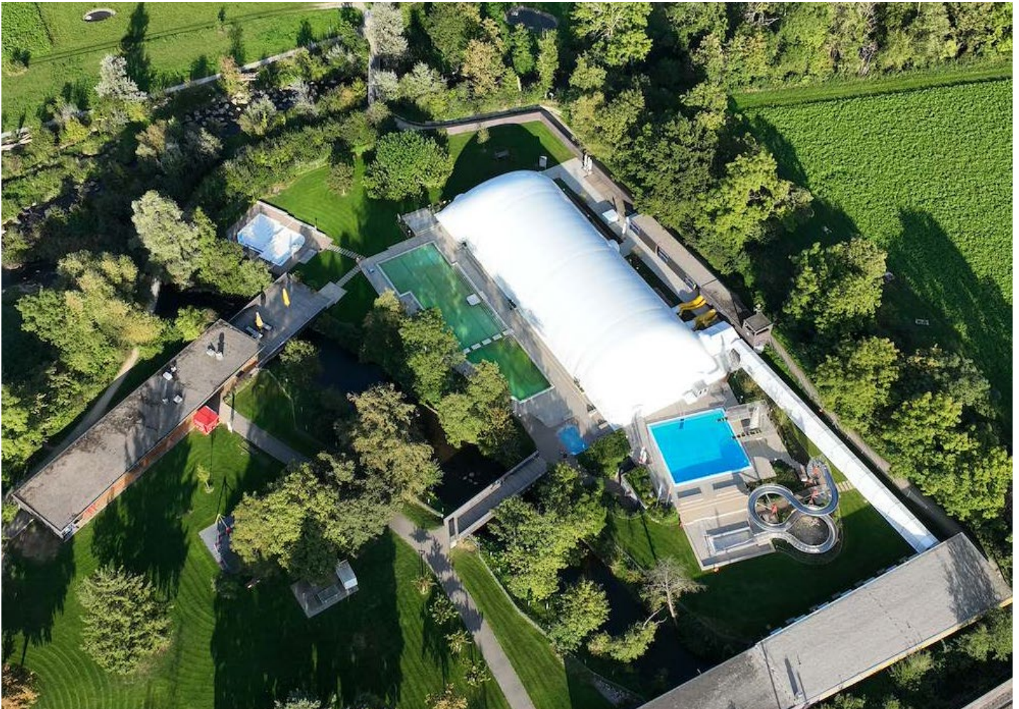
Luftbild der Badi mit Traglufthalle: rechts unten das sanierte Garderobengebäude, rechts neben der Traglufthalle das Lagergebäude für die Technik.
