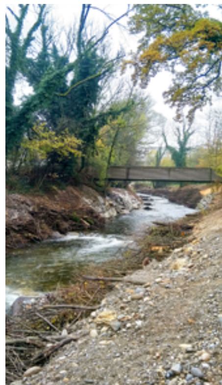
Stabile Sohle durch kleinere Blockschwellen, lebendigeres Ufer dank einer Mischung aus lebendem Material und Totholz.
