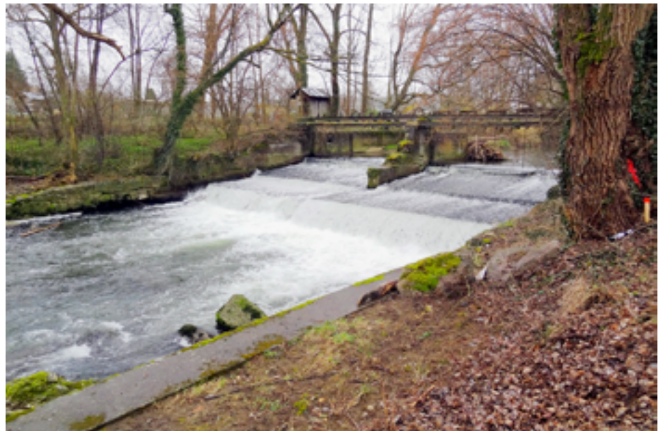
Wehr Lochergrien: unüberwindbare zwei Meter. Auch sprungstarke Forellen können hier nicht weiter!
