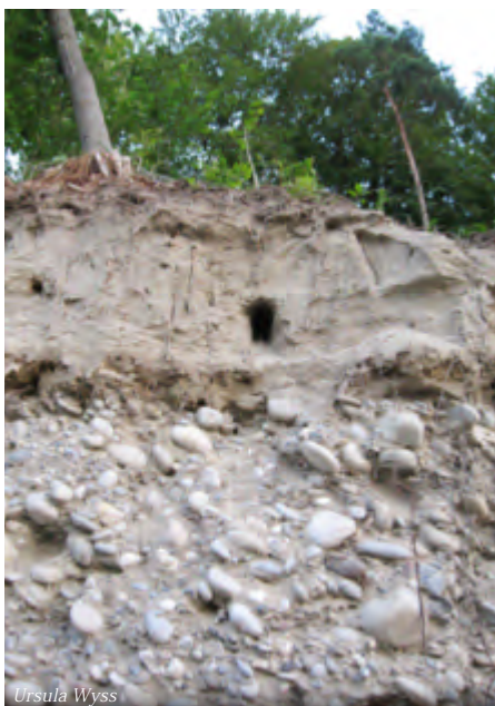
Diese Bruthöhle entstand noch während den Bauarbeiten für den Aarelauf bei Rapperswil.
