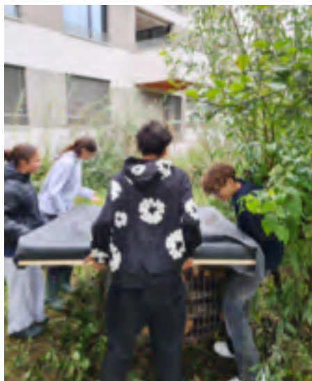
Das Dach wird auf ein Kleintierhotel in der Zopfmatte montiert.
