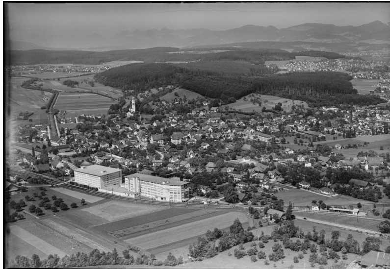
Abbildung 2: Verwaltungsgebäude 1953, Quelle: ETH-Bibliothek Zürich, Bildarchiv
