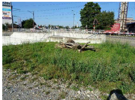
Abb. 2.6 Ausschnitt zu Beginn der Bahnböschung
