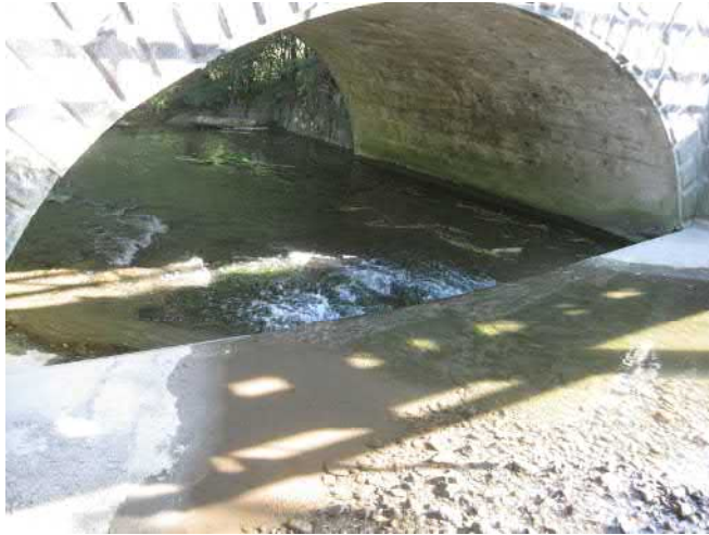
Abb. 6.2 Absturz unter bestehender Wynabrücke
