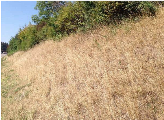
Abb. 2.1 Ausschnitt der Autobahnböschung A1 (Foto: SKK, 20.08.2018)
