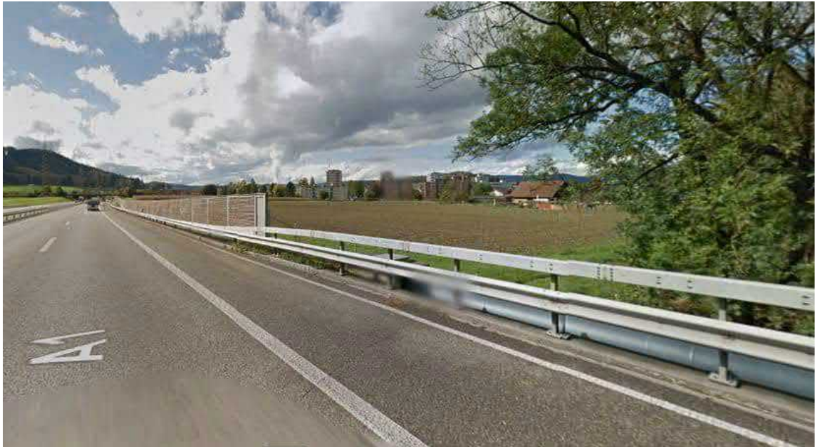
Abb. 1.3 Östliches Ende der Lärmschutzwand beim Wynadurchlass (Quelle: Street View)
