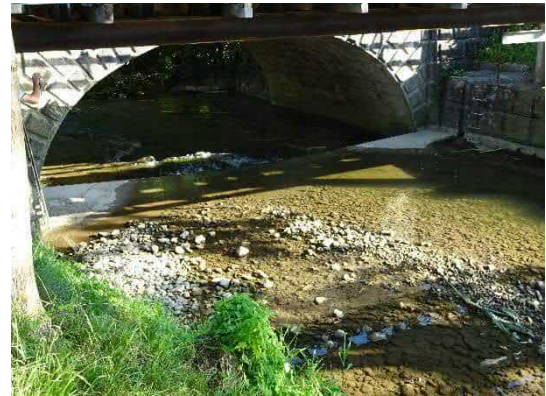
Abb. 2.8 Brücke der Bernstrasse Ost
