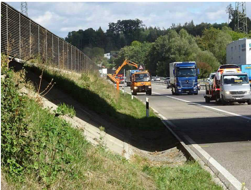
Abb. 1.2 Widerlagerbereich unter der Kantonsstrassenbrücke / AVA Brücke mit Plattenbelag und Halbrundschaale
