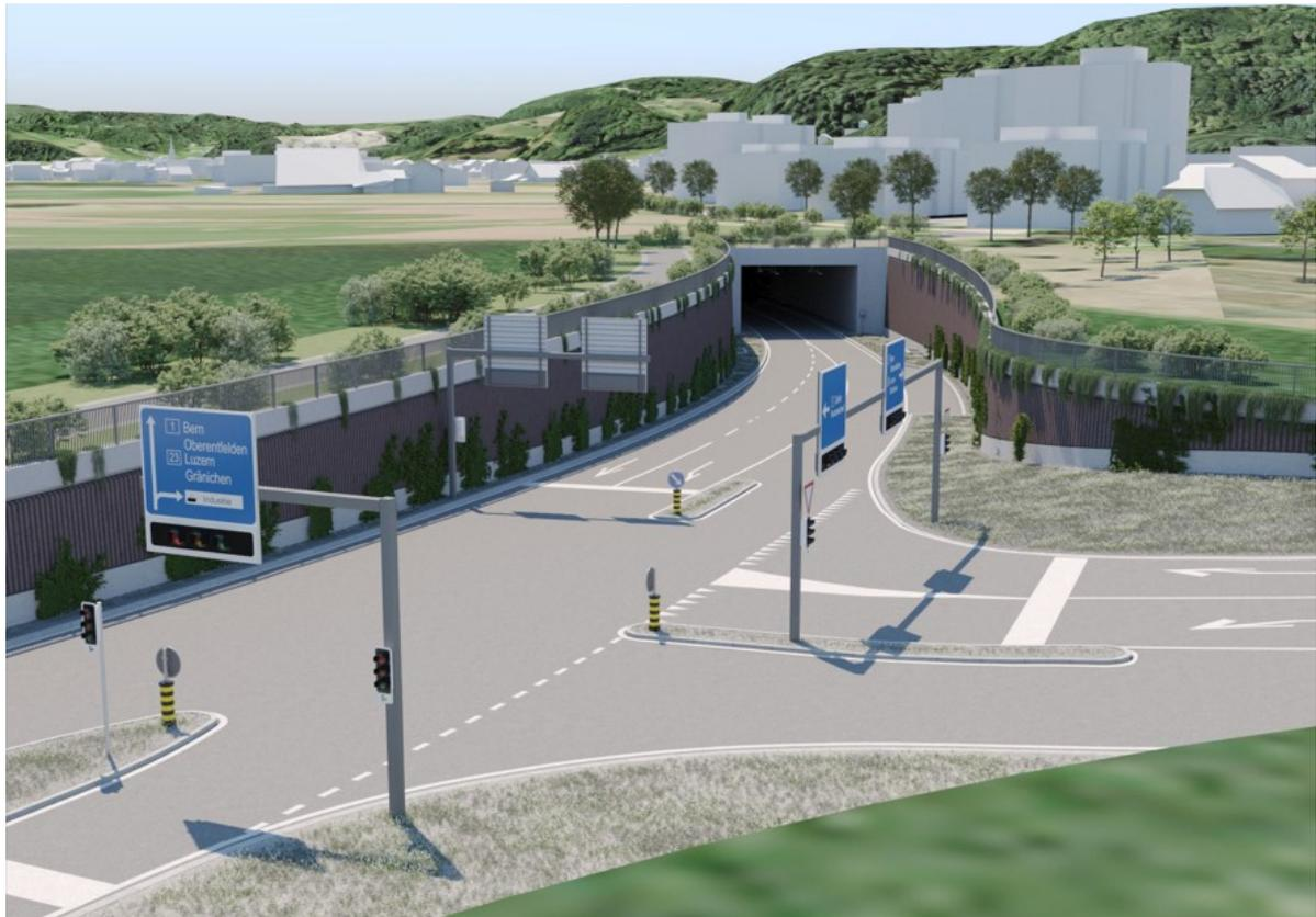
Vom Knoten Hintere Bahnhofstrasse führt das Trasse der NK241 über die Grundwasserwanne Wynematte zum Tunnelportal Wynematte. Um die Siedlung bestmöglich vor Strassenlärm zu schützen und Fruchfolgeflächen (FFF) zu schonen, wird entlang dem Buhalde-Quartier ein 843 m langer Tagbautunnel gebaut. Der Tagbautunnel ist unterteilt in einen 600 m langen Abschnitt mit Gewölbequerschnitt vom Portal Wynematte bis östlich des Bahntrassees der AVA und einen 243 m langen
