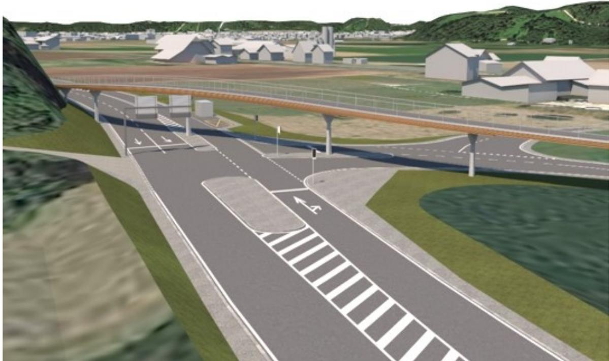
Vom Knoten Hürdli wird die NK240 an die Autobahn A1 geführt. Der A1 folgend, führt die Kantonsstrasse in erhöhter Lage zum Freileitungsmast Nr. 39 der Swissgrid AG, unter der neuen Überführung Langmattweg (N1-215) à Niveau hindurch bis zum Knoten Helgenfeld. Der Freileitungsmast wird hierbei einbetoniert, um trotz der geringen Abstände zum Fahrbahnrand einen genügenden Anprallschutz zu gewährleisten.
