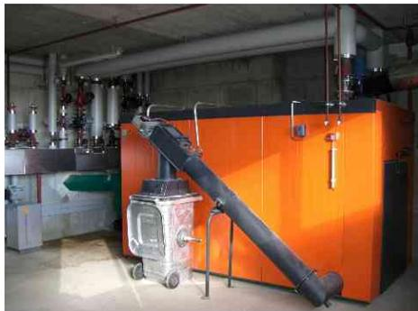
**Abbildung 11** Holzschnitzelkessel eines Wärmeverbundes (Quelle: [www.bossert-forst.ch](http://www.bossert-forst.ch)).
